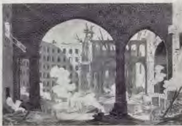
IL TEATRO SAN CARLO DOPO L'INCENDIO DEL 1816. Disegnato da G. Pignatelli.
