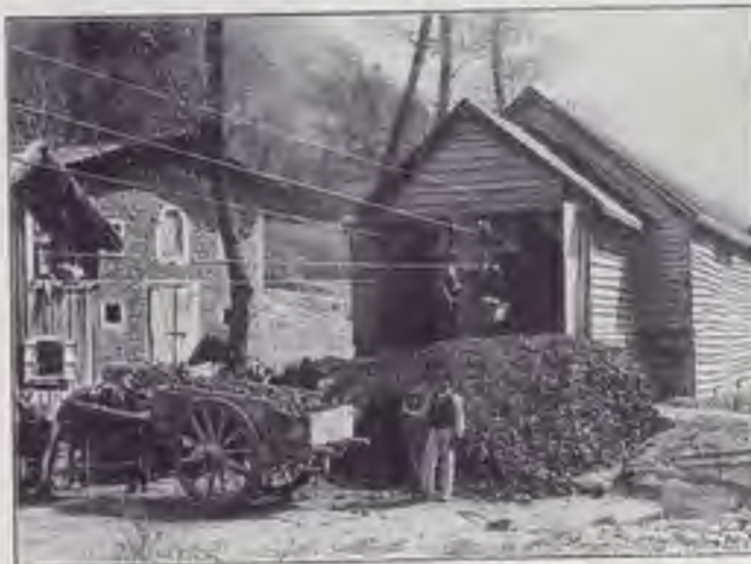
ULTIMA STAZIONE DEI TRASPORTI AEREI, SOTTO CORSO. IL MINERALE VIEVE CARICATO SUI CARRE PER ESSERE PORTATO ALLA STAZIONE DI PONTE DI NOVA.
