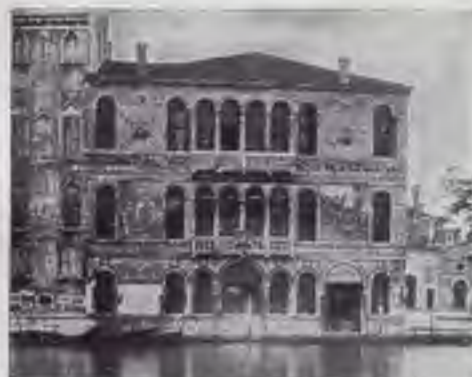
PALAZZO DA MUCA, SUL CANAL GRANDE. Proprietà e sede della Conceria di Venezia-Murano.
