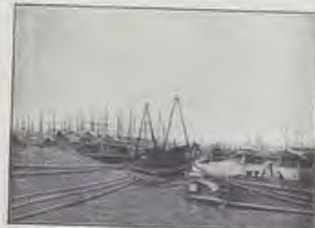
18. - DEMOLIZIONE DELLA CARCASSA DI UN GRANDE VAPORE.
