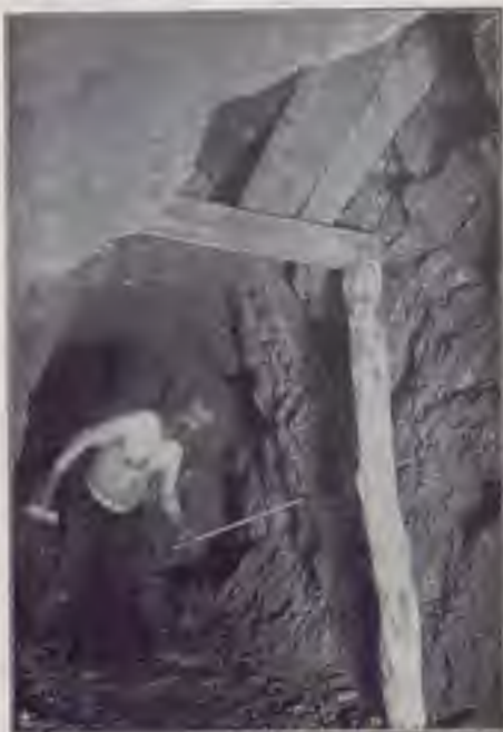
OPERARIO CHE BATTE UNA MINA.
