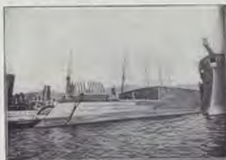
16. - L'INCROCIATORE FRANCESE "DUQUESNE" IN DEMOLIZIONE.
