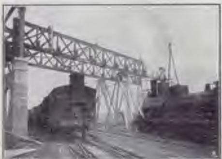
IL VIADOTTO SULLA STAZIONE DI Sperimento. Vista attuale del lavoro.
