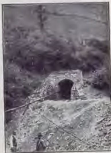
INGRESSO A UNA GALLERIA. SI VIDE IL TUBO DEL VENTILATORE.
