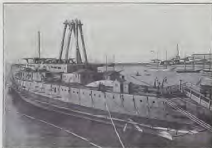
10. - LA CORAZZATA "NAPOLI" IN ALLESTIMENTO.
