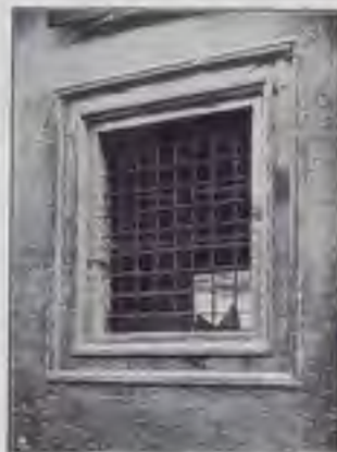
* FINESTRA IN TERRA COTTA alla antica Casa dei Borromei in via Duomo.
