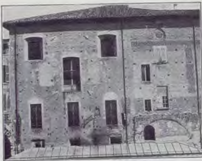
IL PALAZZO DEL COMUNE (BOLOGNA) PRIMA DEL RESTAURO di Alfonso Rubbiani.
