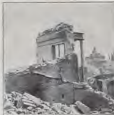
IL VILLAGGIO SOCCUBITO E DISTRUTTO DALLA LAVA A TORRE ANNUNZIATA.
