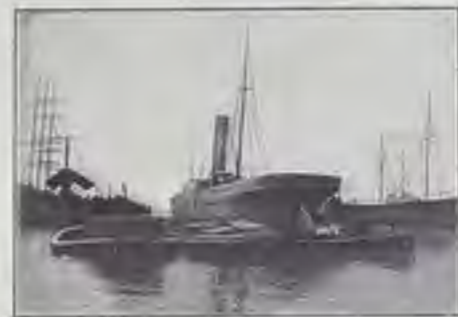
12. - VAPORE IN DISARMO.
