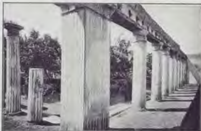
ERCOLANO: CASA DI ARGILTO.
