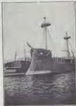
15. - LA CORAZZATA FRANCESE "FRIEDLAND" IN DEMOLIZIONE.
