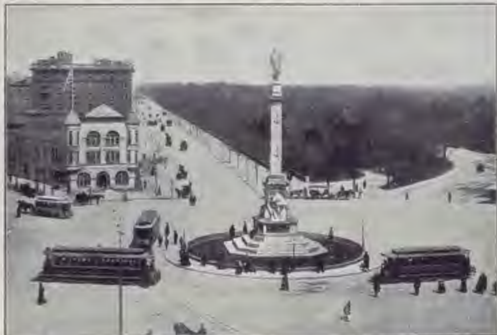
IL MONUMENTO A COLOMBO E IL CENTRAL PARK DALLA 59. a STRADA.
