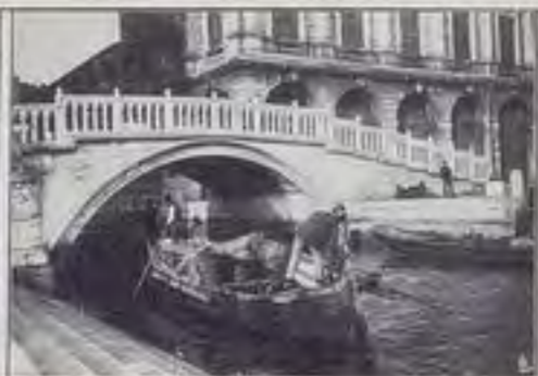
LA BARCA DELLA VERDURA ENTRA NEI CANALI.
