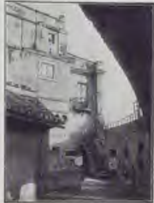
11. - INGRESSO ALL'ALLOGGIO DEL CASTELLANO.
