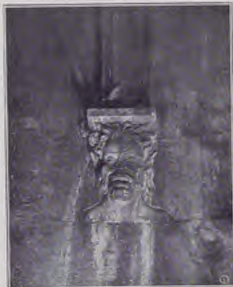
CASTEL DEL MONTE - ALTRO MANCIERONE D'UNA MENSOLOLA DI SOSTEGNO.
