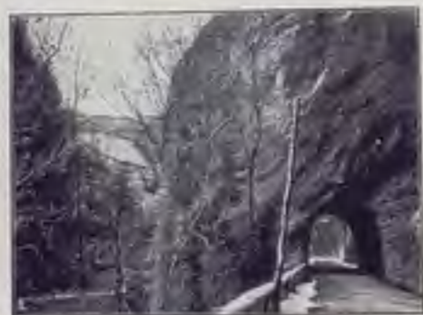
IN VALGANNA - IL PRIMO TUNNEL
