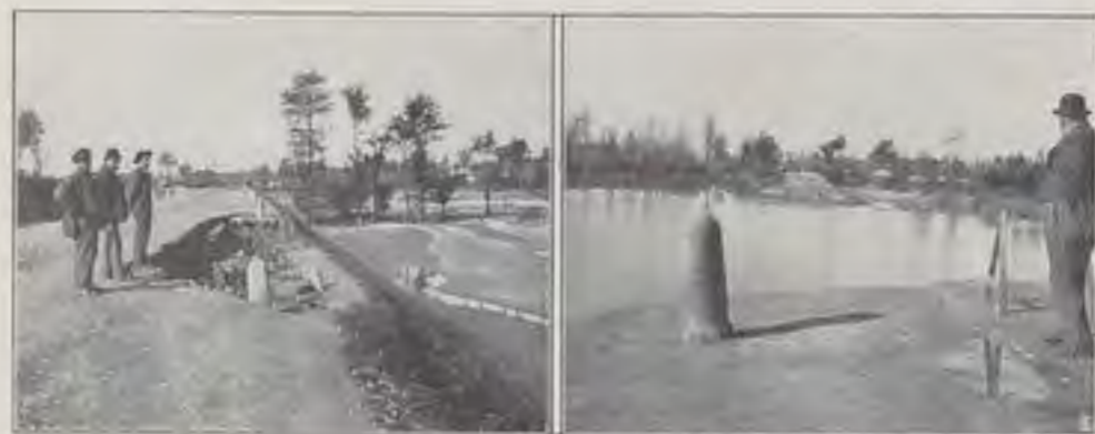
Inalزامento di 3 metri di parte della strada.
