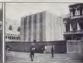
Fot. G. Ricordi, Venezia. Lo stato odierno dei lavori di ricostruzione.
