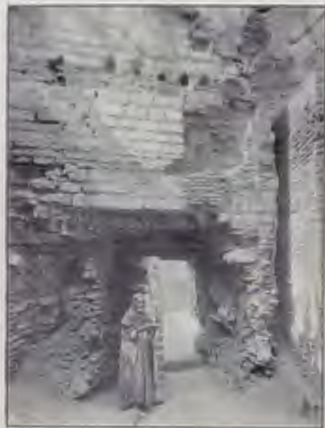
CAIRO - PORTA D'UNA CASA IN RUINA.
