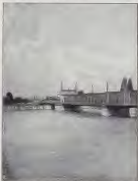
IL PONTE DI FERRO NEL BASSO A STRASBURGO.
