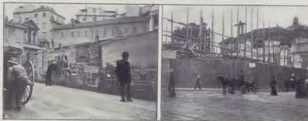
Demolizioni in via Bassano Porrone.
