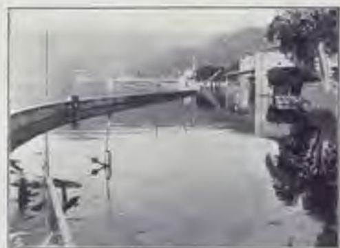
Come è ridotta la linea ferroviaria Luino-Lugano.
