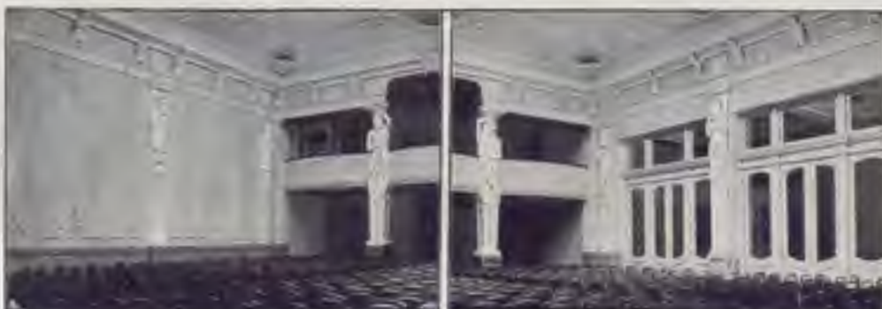
SALA VISTA DAL LATO OPPOSTO AL FOYER.
