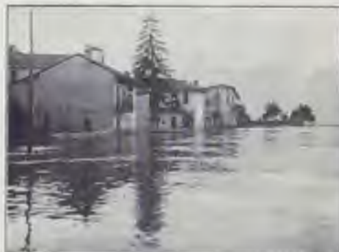
Gormignaga - Le case minacciate dall'acqua.
