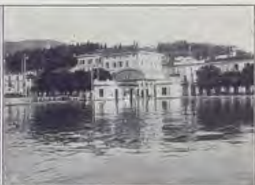
L'imbarcadere dei piroscafi a Luino coperto dalle acque.
