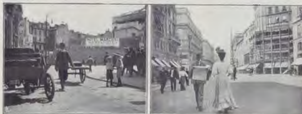
Demolizione del Bocchetto.
