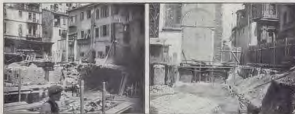
Demolizioni in via Spadari.
