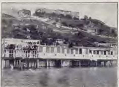
Foto Biondi. STABILIMENTO BALNEARE E CASTELLO.
