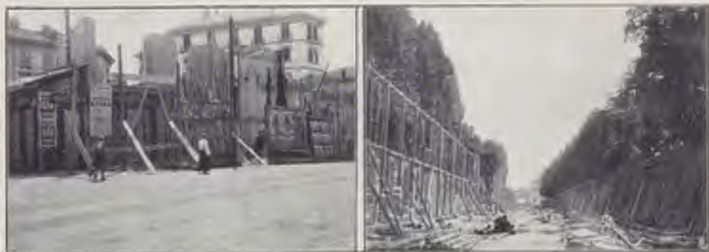
Demolizioni in Corso Magenta.
