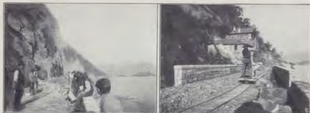
Le ultime mine alle rocce presso Arregno.
