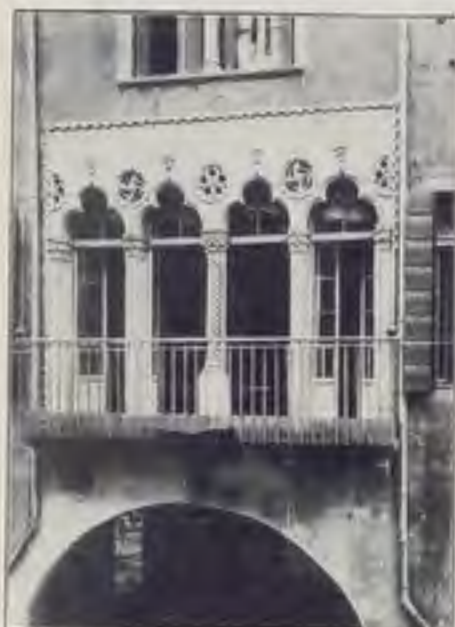
16. - ALTRO FINESTRE CON TORRE.
