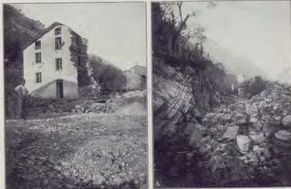
Una casa inutilata per far posto alla nuova strada presso Colombo.
