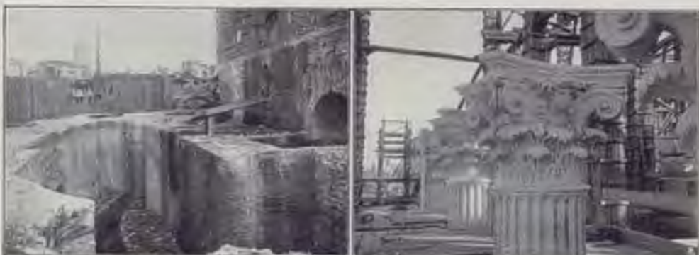
Lavori di abbassamento del piano. Il primo abbassamento fu compiuto dal Sacconi. Ora la piattaforma verrà abbassata di m. 1,70.
