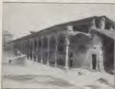
ESTERIORI - VEDUTA DEL LAZZARETTO DA L'OPPORTUNA VEDUTA VIALE GARIBOLDI (INTERNO).
