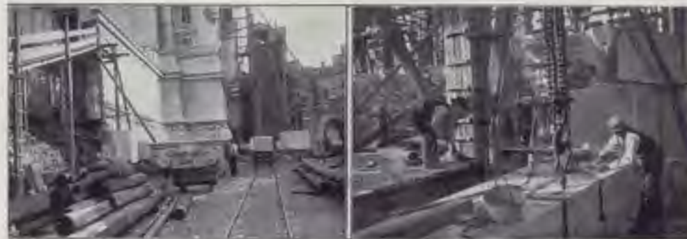
Il cantiere. - Il trasporto del blocco.
