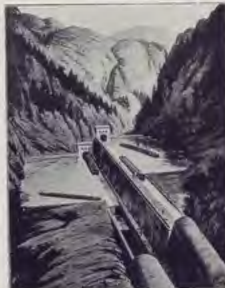
LE INDOCCAZIONE SUPERIORE E INFERIORE DEI DUE CANALI CON RISPETTIVI SACCHI LATERALI A DIFFERENTE LIVELLO.
