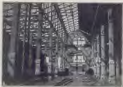
71. - MACELLO ROVATI - LA TETTOIA IN FERRO.
