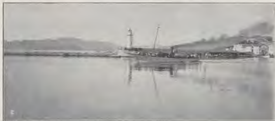
PORTO DI CANNES - LA DIGA.
