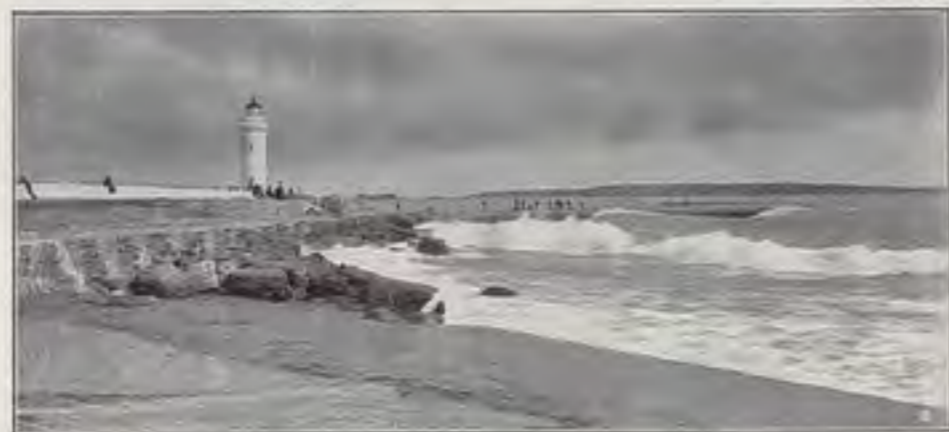
PORTO DI CANNES - LA DIGA.
