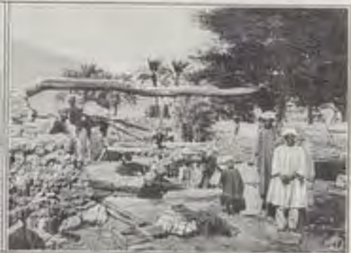
POZZO D'ACQUA A LUSOR MIRSO IN EQUINOZIO MIRSIANTE IN CAHRSLEO.
