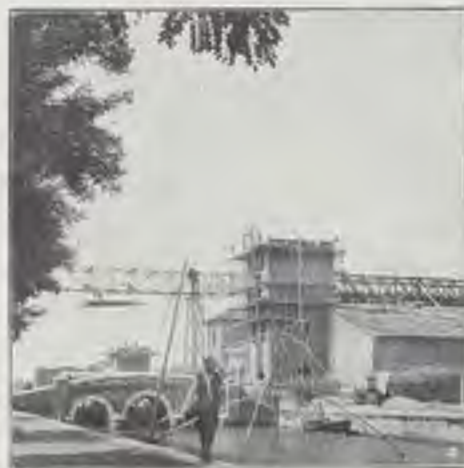
MAGAZZINI NUOVI IN COSTRUZIONE.
