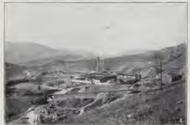
CANTIERE VISTO DALL'ALTO.
